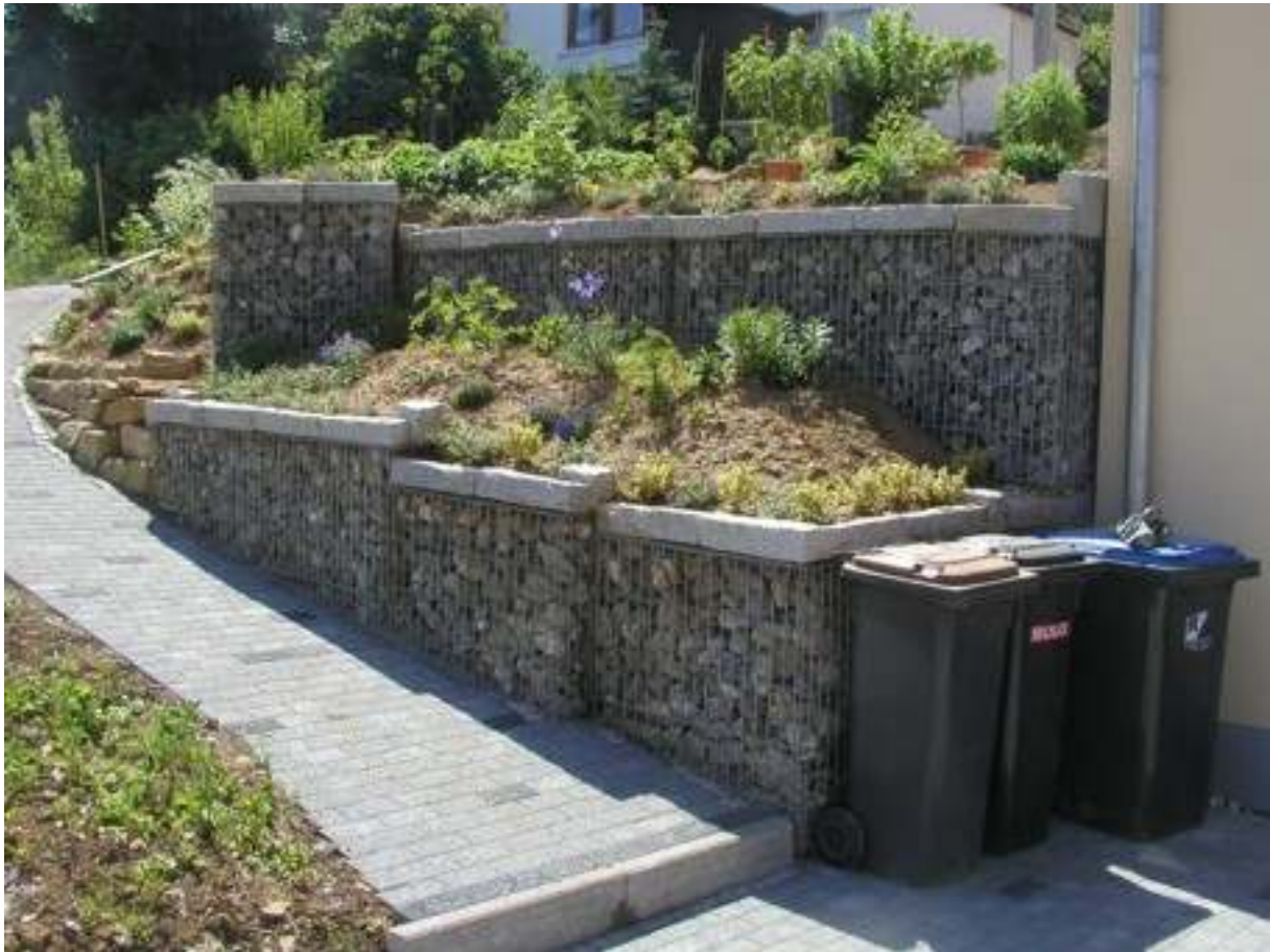
Anwendungsbeispiel: Steinkörbe im Hanggrundstück
