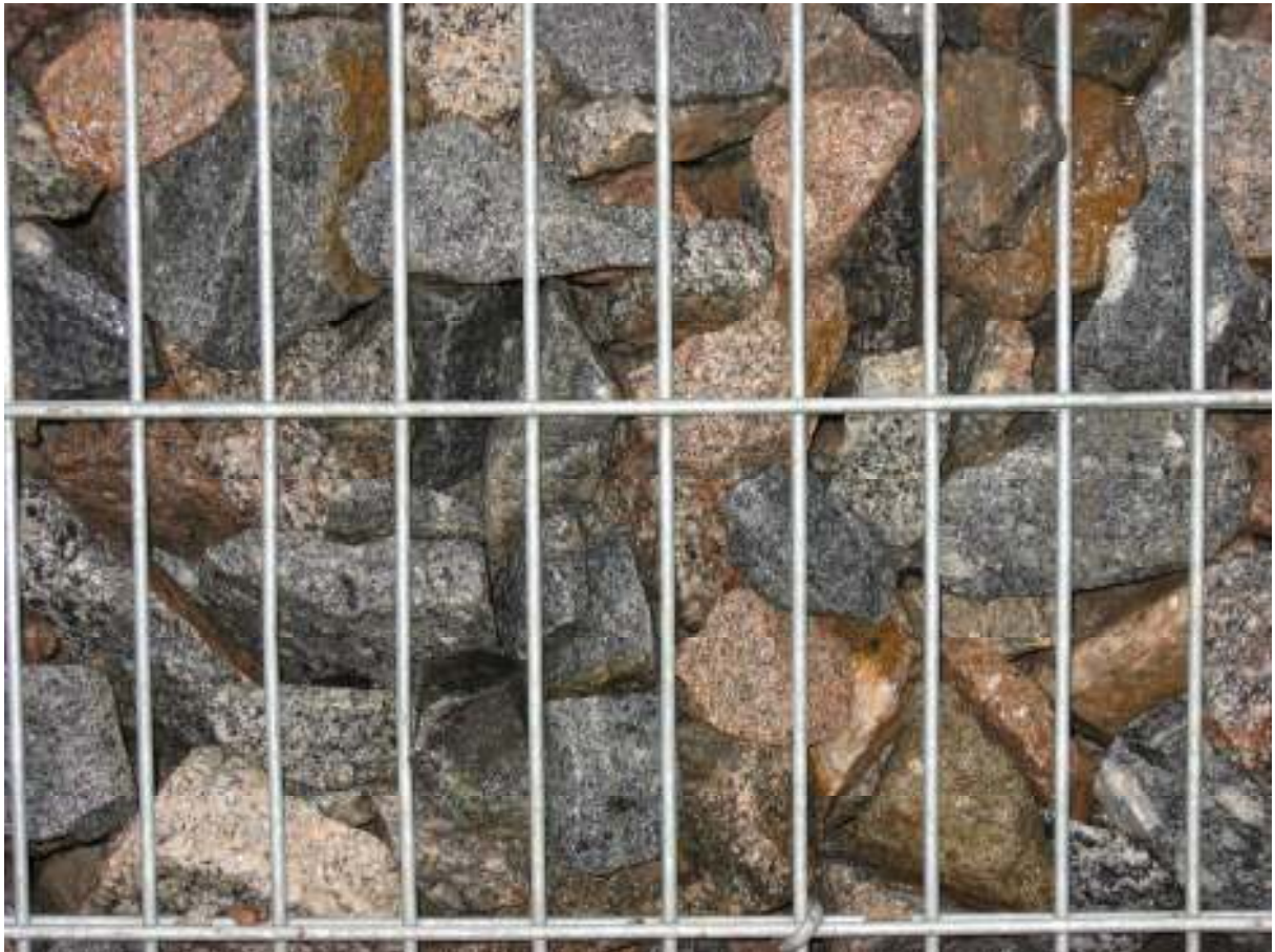
Steinkörbe, Ausführung geschüttet
