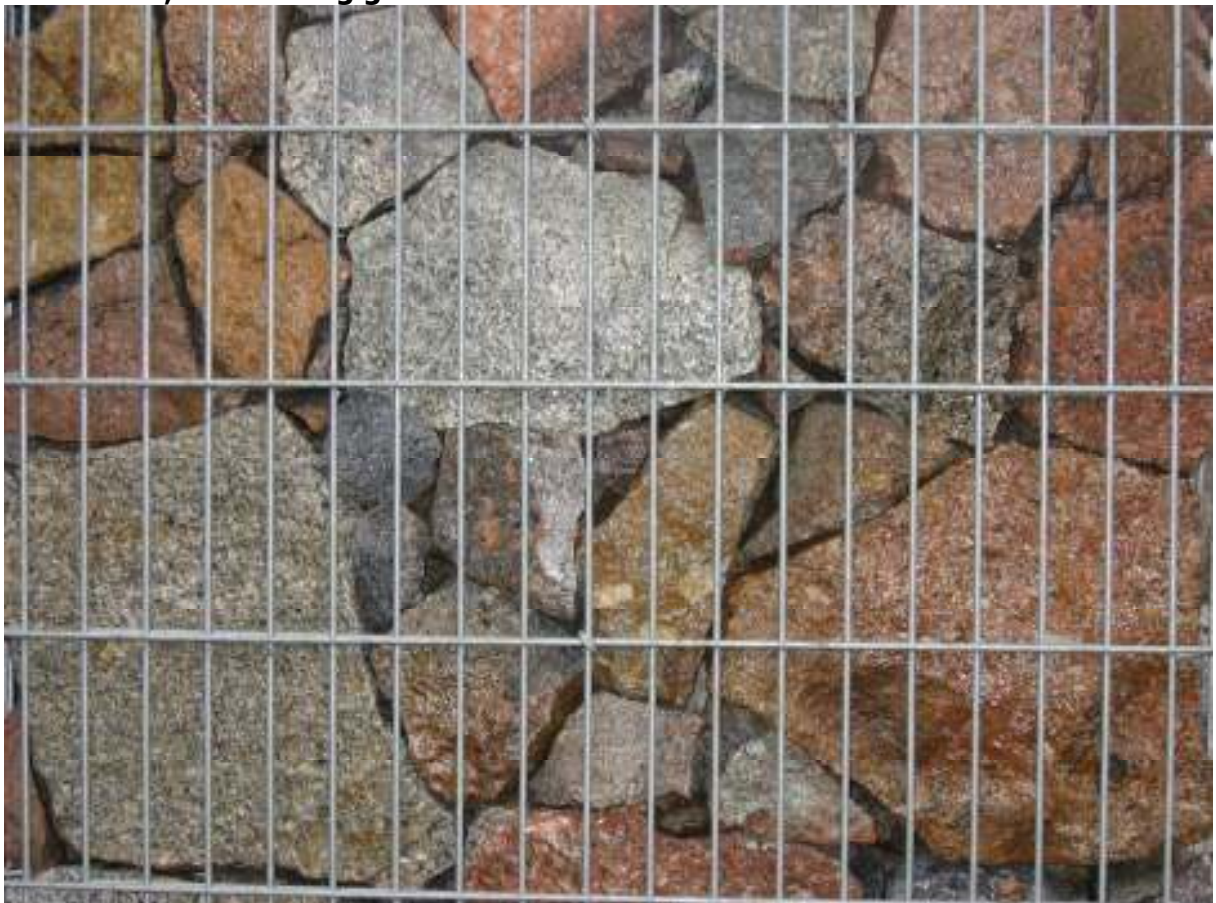
Steinkörbe, Ausführung geschichtet
